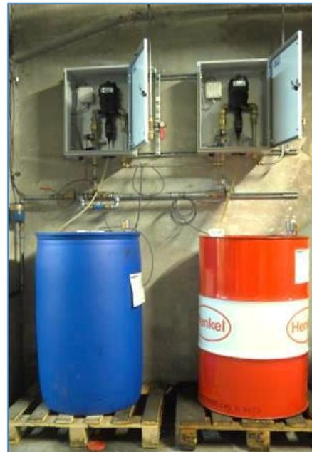
**Abbildung 2: Die Mischstation sorgt für konstante Mischverhältnisse bei dem eingesetzten 2-Komponenten KSS von Henkel**
